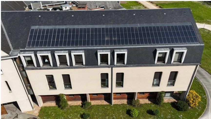
L'installation sur la toiture de l'Ehpad Dujarié
