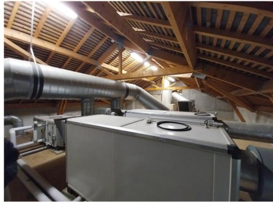
Ici, les systèmes de ventilation de l'EHPAD sont situés sous une toiture ardoise.
