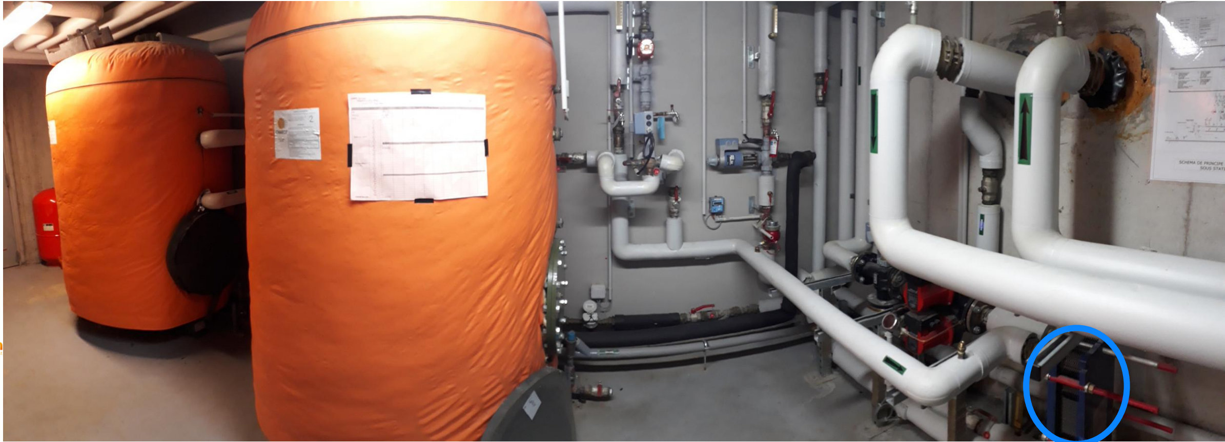
Échangeur ECS (60°C sur primaire chaudières)
