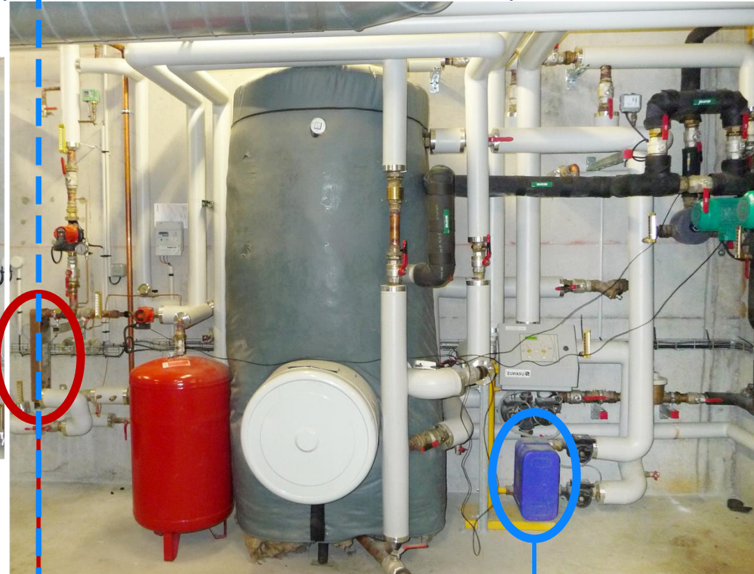
Échangeur ECS (60°C sur primaire chaudières)
