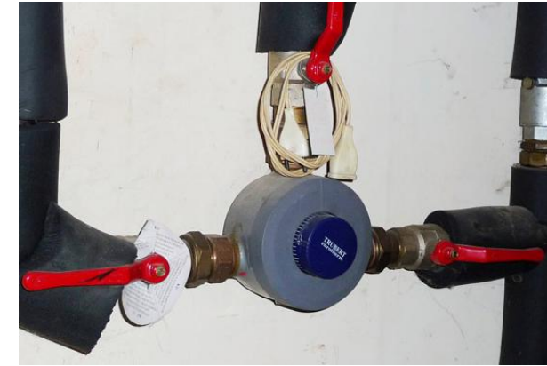
Mitigeur thermostatique collectif
