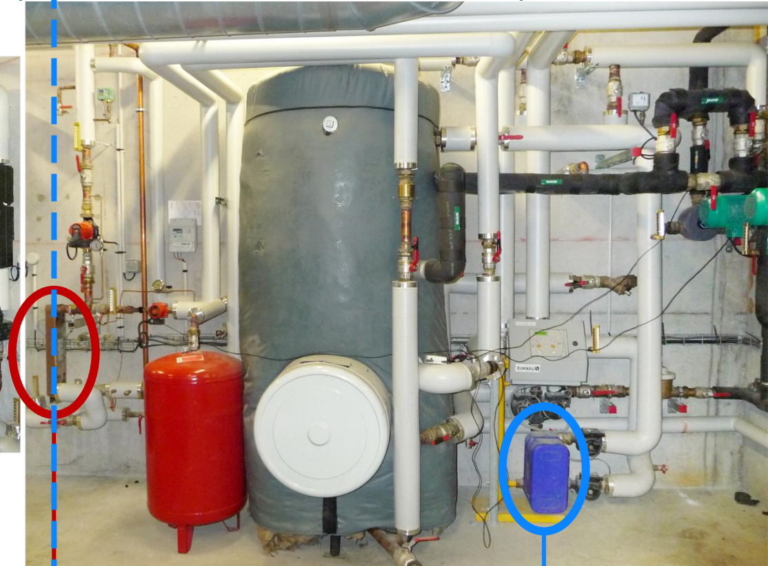
Échangeur ECS (60°C sur primaire chaudières)
