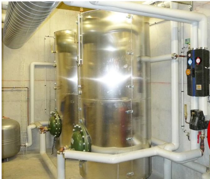
Ballons solaires (volume technique 2x1000 L en eau morte)
