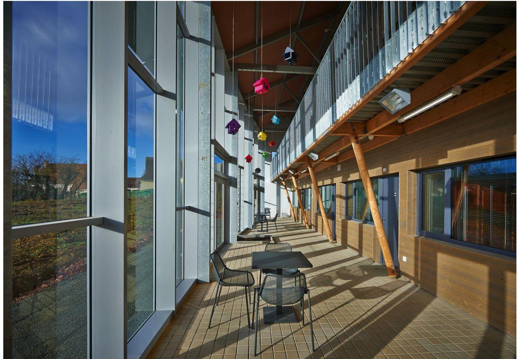
Un espace tampon bioclimatique, avec des matériaux « rustiques », en contraste avec l'intérieur des logements. L'ADAPEI de la Sarthe, est très engagé dans l'emploi des matériaux bio-sourcés et d'énergies renouvelables.
