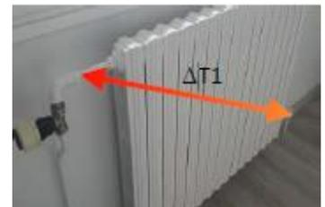
L'écart de température peut être quantifié « à la main » (imprécis) ou avec un « thermomètre infrarouge » (précis).
