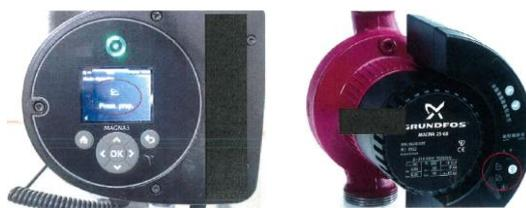
Le kit manométrique présent sur les circulateurs des circuits secondaires chauffage permet d'ajuster le débit aux besoins de chauffage.
