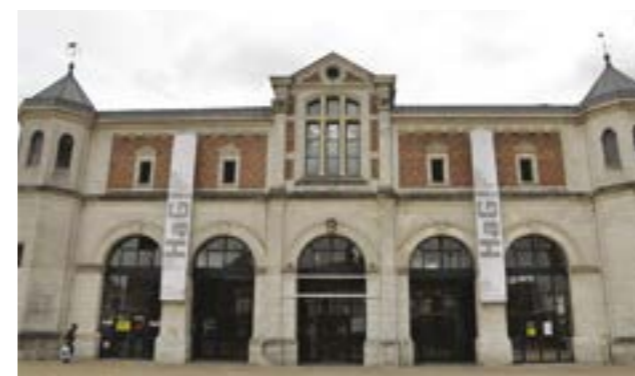
Halle aux grains de Blois © S2e2, Région Centre-Val de Loire
