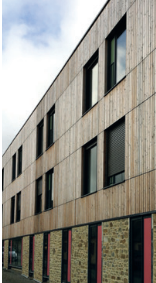
Hôpital local de Croon (53) | Architecte Ameller&Dubois | © Atlanbois
