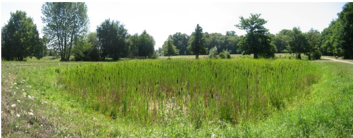
Figure 7 : filtre à sable planté de roseaux à Saint-Gilles près de Rennes
