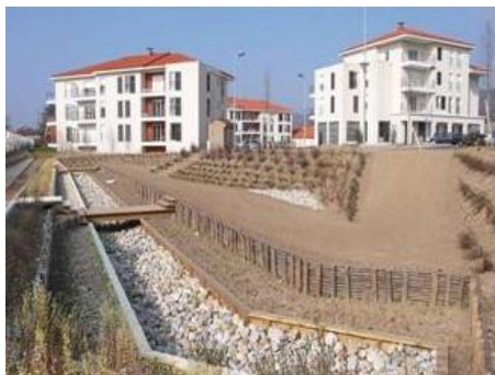
Bassin paysager d'infiltration à dominante minéral en Savoie (73)
