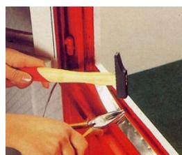
Figure 2: Pose d'un joint métallique
